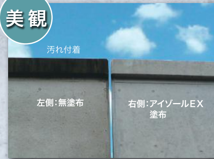
高架橋 施工後9年
