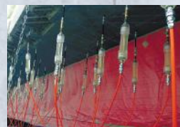
床版下面施工
