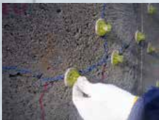
座金設置状況
